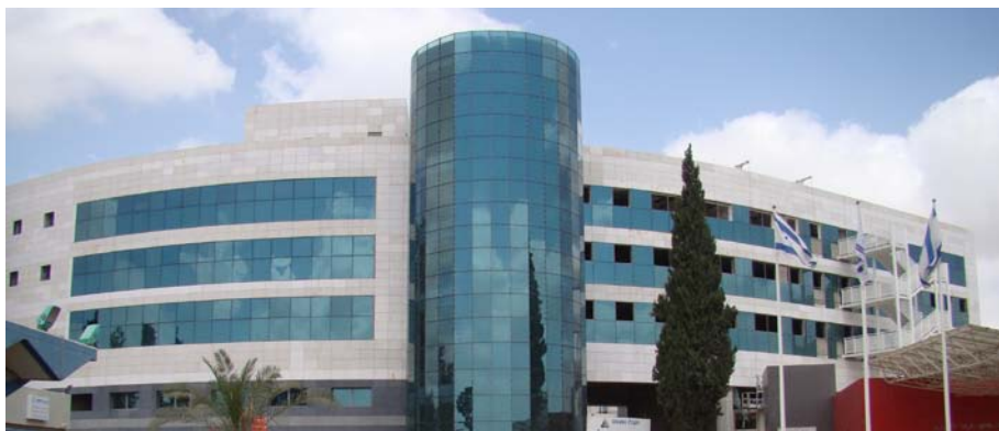
Un nouveau bâtiment de l'hôpital « Assaf Harofeh »
