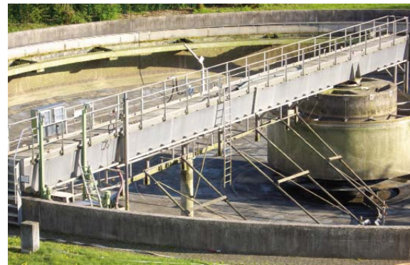
Les Palestiniens ont reçu de fortes sommes de l'étranger pour construire des stations d'épuration d'eau, mais ne les ont pas réalisées. Ils ont dépensé cet argent à d'autres fins
