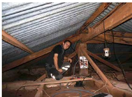
Obed Hanisch refait les branchements dans la maison de Tonnie de Jong.
